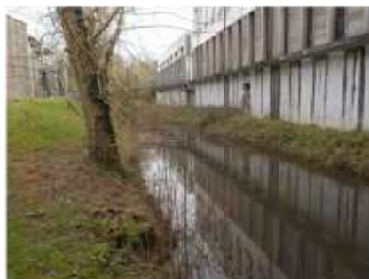
Vue vers l'amont
